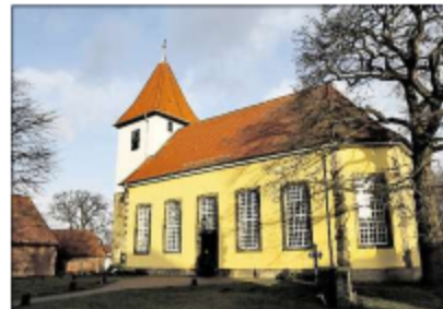
Auch die Dreieinigkeitskirche in Kirchwehren muss mit weniger Ressourcen auskommen. Bartels (2)
